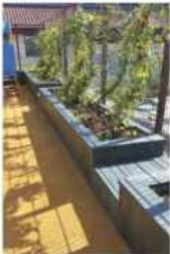
Rénovation de jardinières existantes
