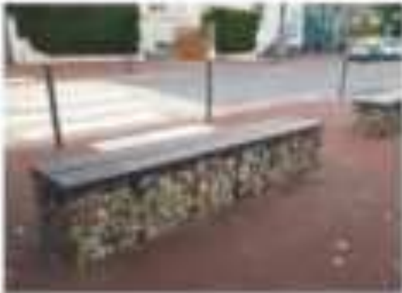
Assises sur gabions
