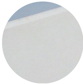
béton blanc lisse brut (aspect mat)
